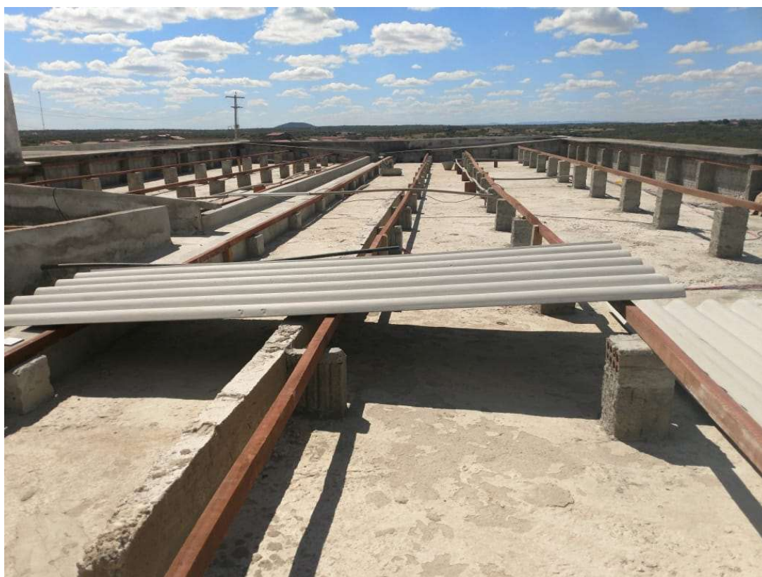
Imagem 14: Laje descoberta e identificação da localização de viga invertida. (Foto cedida)
