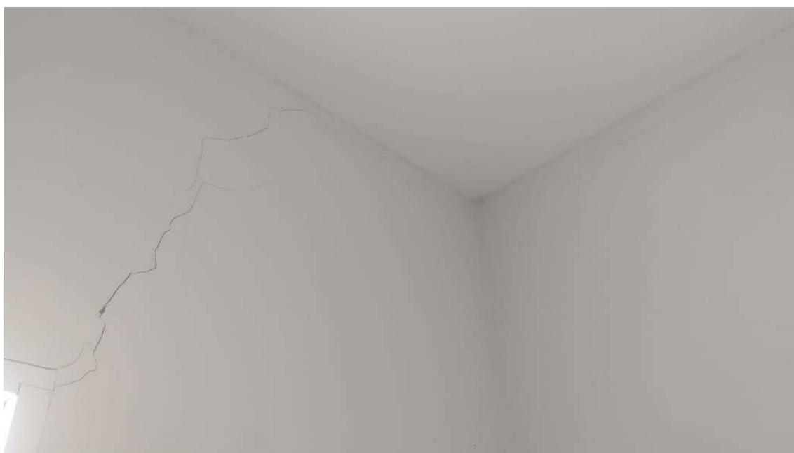
Imagem 17: Trica oriunda do deslocamento da edificação sem contenção de verga. (Foto cedida)
