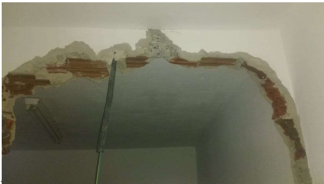
Imagem 21: Intervenção interna para abertura de vãos com identificação de cintas superiores. (Foto cedida)
