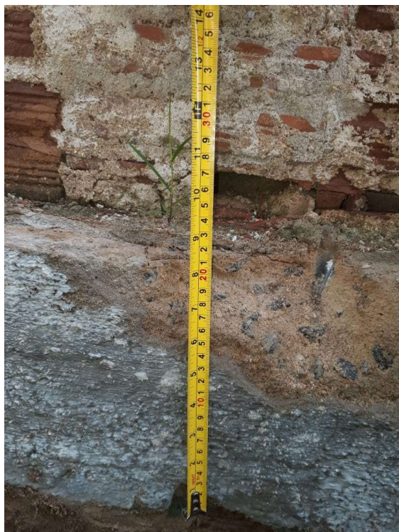
Imagem 03: Fundação existente. Cinta inferior.
