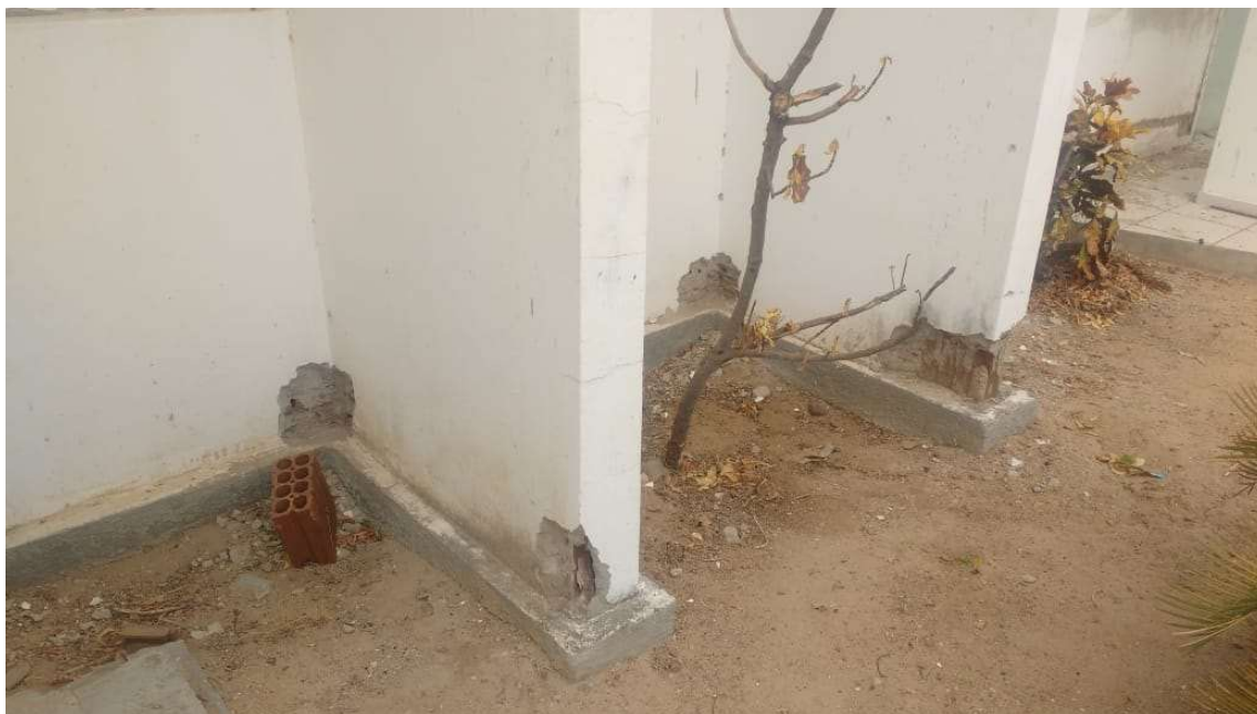
Imagem 19: Intervenção na fachada para identificar possíveis pilares. (Foto cedida)
