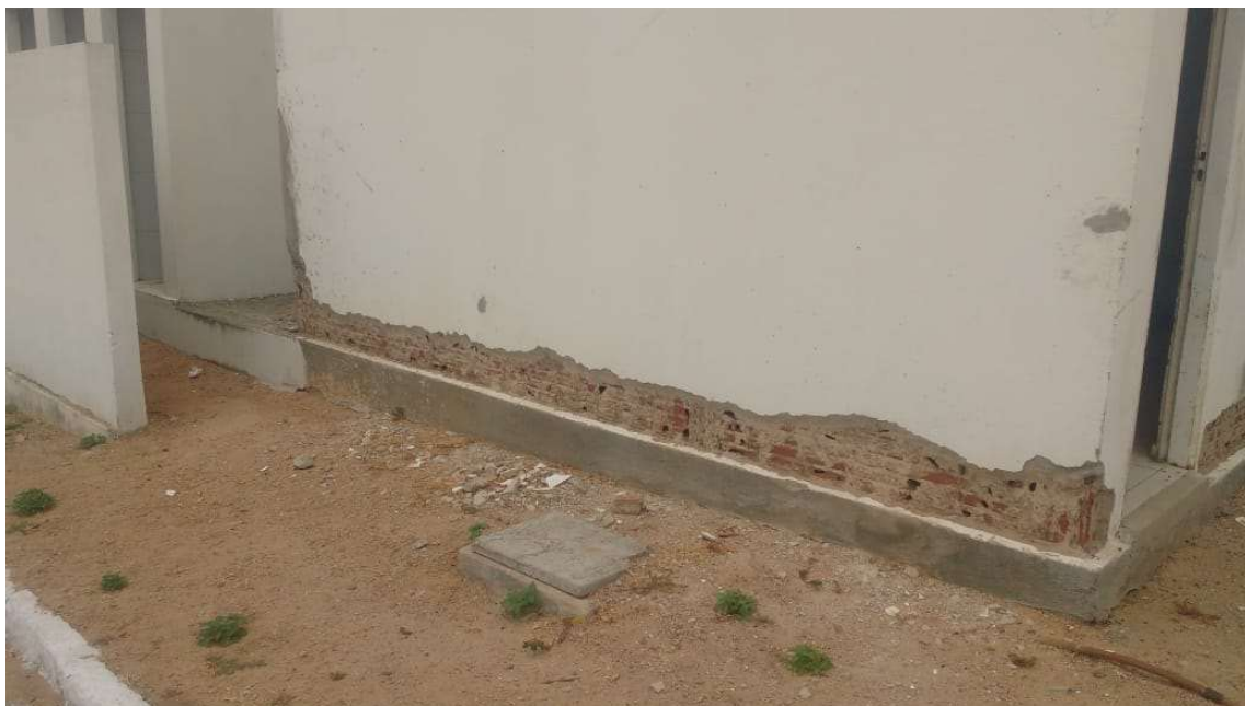
Imagem 20: Intervenção na lateral esquerda para identificar possíveis pilares. (Foto cedida)
