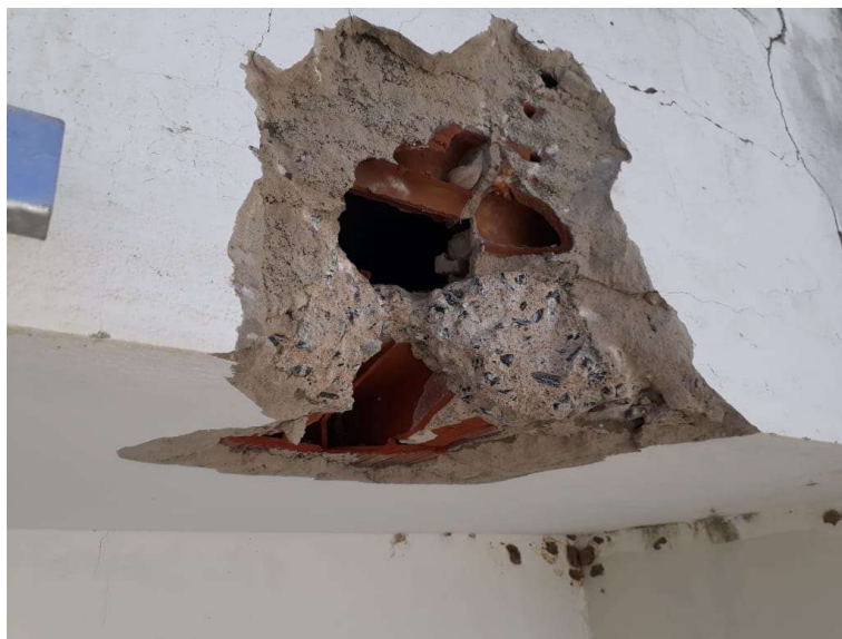
Imagem 12: Constatação de inexistência de viga de borda no beiral.
