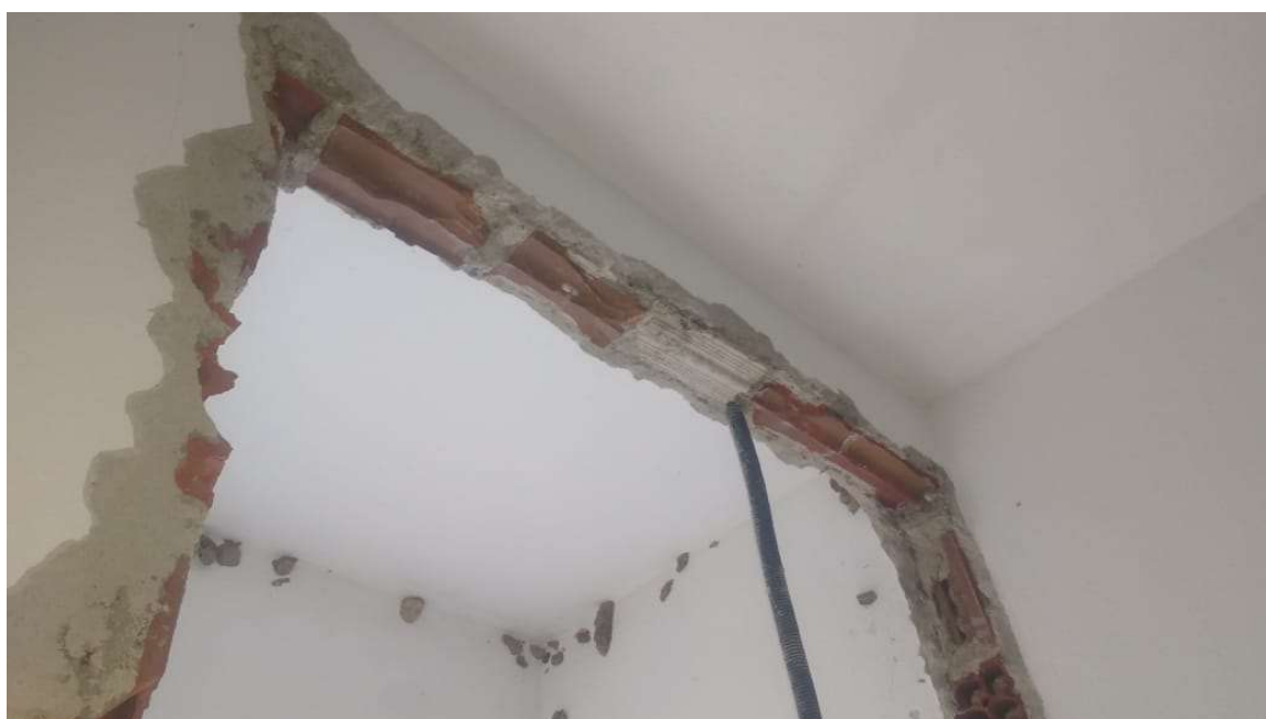
Imagem 25: Intervenção interna para abertura de vãos com identificação de cintas superiores. (Foto cedida)
