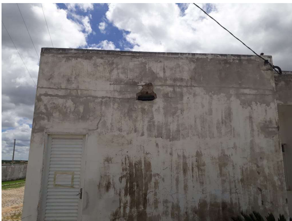
Imagem 06: Investigação para identificação de área de aço longitudinal e transversal.
