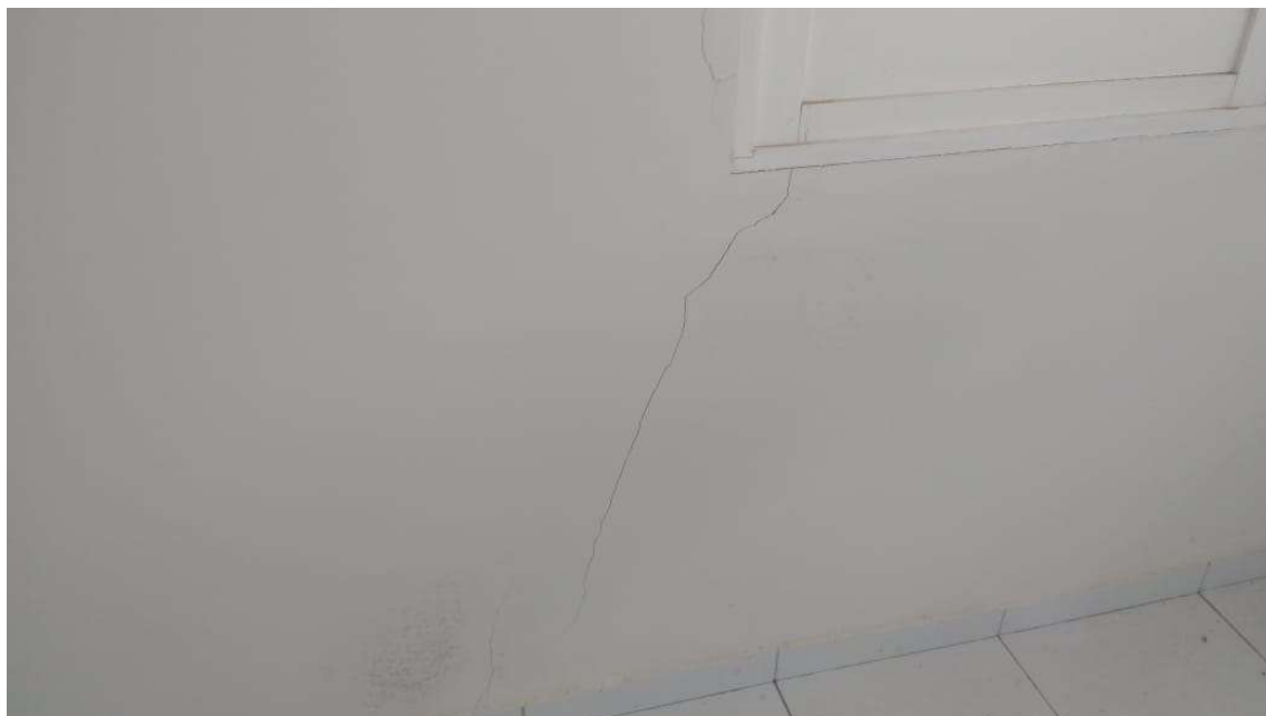
Imagem 22: Trica oriunda do deslocamento da edificação sem contenção de contra verga. (Foto cedida)
