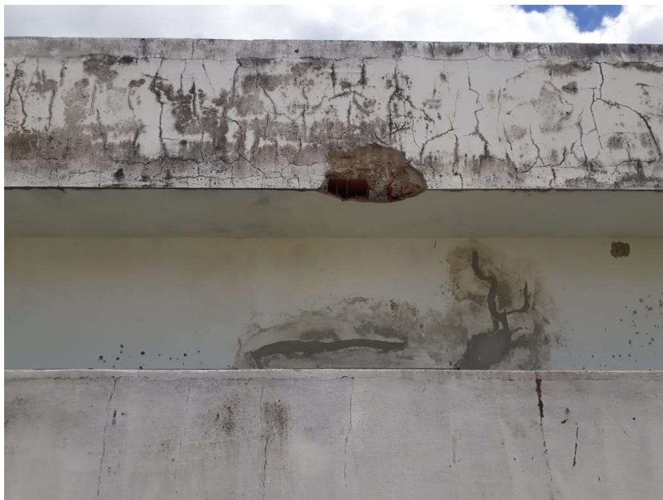
Imagem 09: Constatação de direção de vigotas da laje – fachada posterior.
