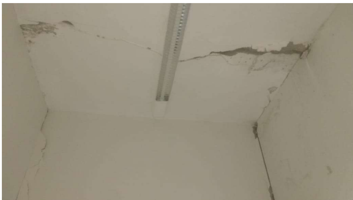
Imagem 23: Junta seca formada na parte interna do prédio onde não foi executada amarração entre as partes, beiral em laje x forro de gesso. (Foto cedida)
