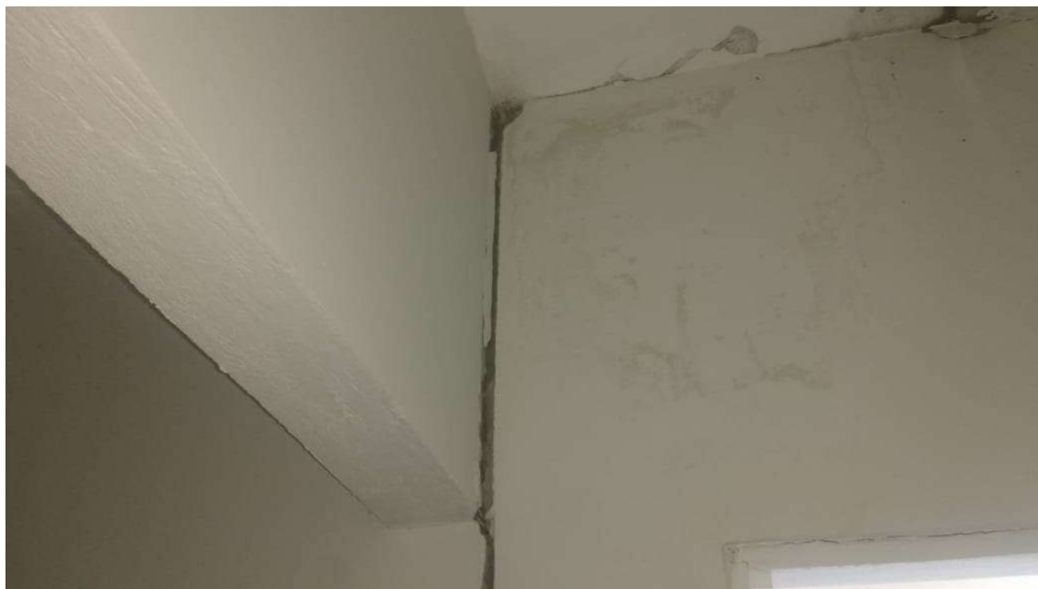
Imagem 18: Junta seca formada na parte interna do prédio onde não foi executada amarração entre as partes. (Foto cedida)
