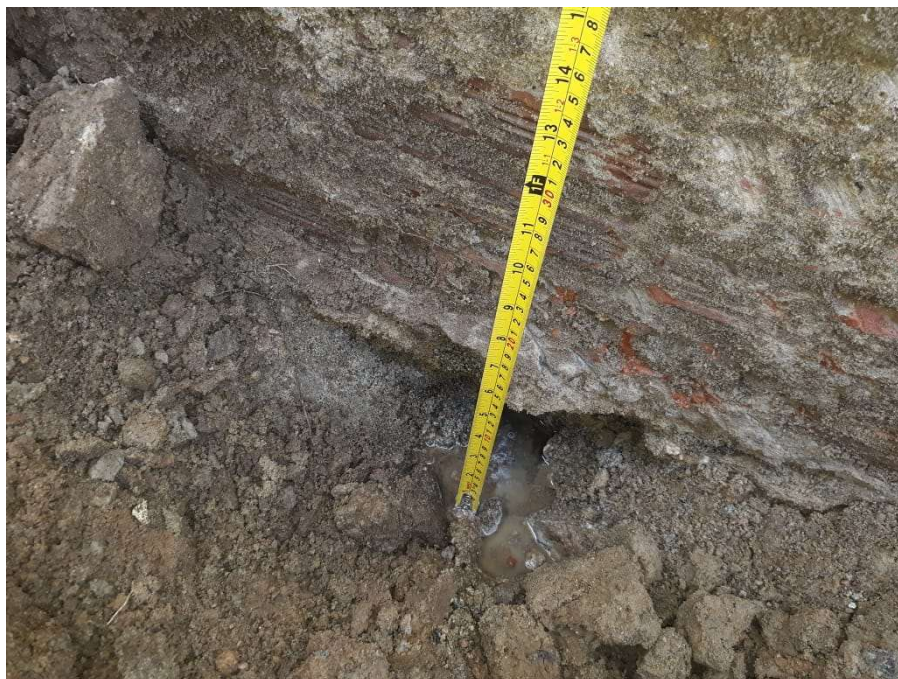
Imagem 02: Fundação existente com manifestação de lençol freático.
