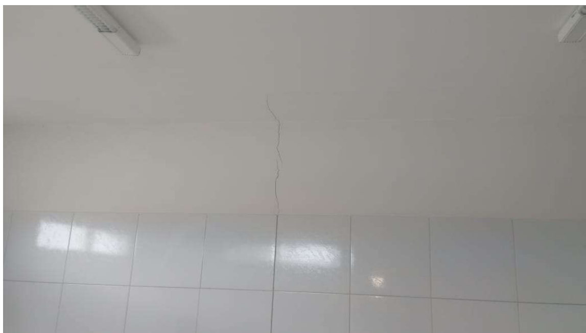
Imagem 24: Junta seca formada na parte interna do prédio onde não foi executada amarração entre as partes. (Foto cedida)
