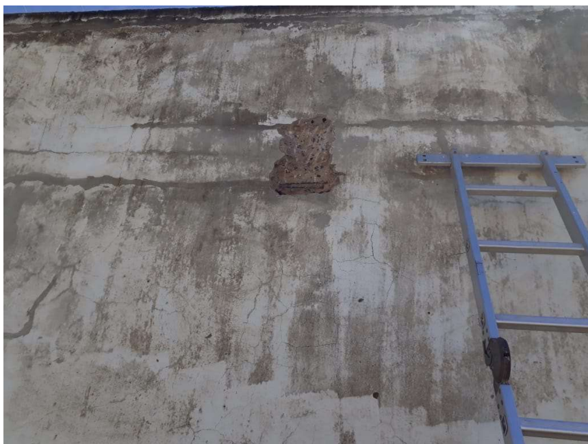
Imagem 05: Local da Imagem 04. Constatação da existência de viga.
