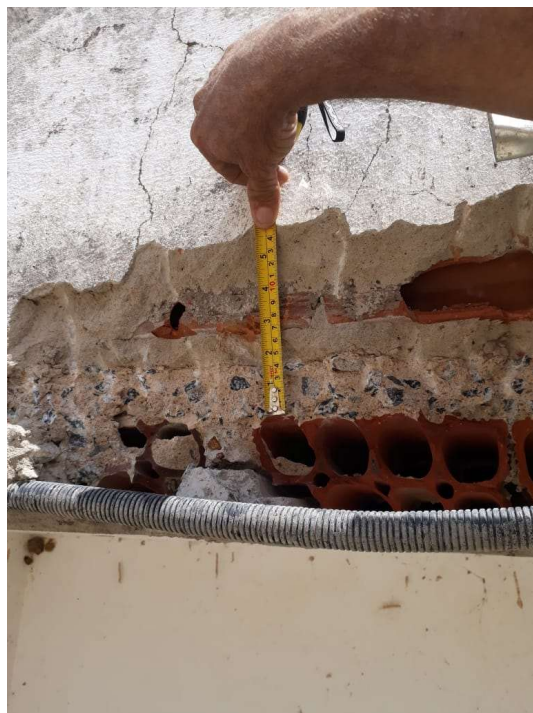
Imagem 11: Constatação de espessura de capa de concreto da laje e inexistência de viga de borda.
