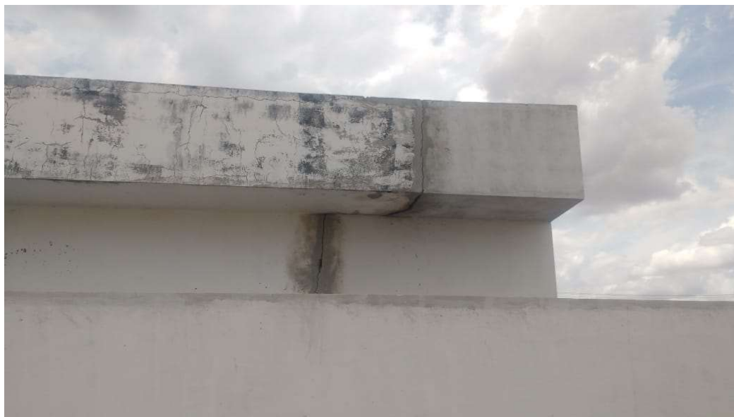
Imagem 16: Junta seca formada na parte posterior do prédio onde não foi executada amarração entre as partes. (Foto cedida)
