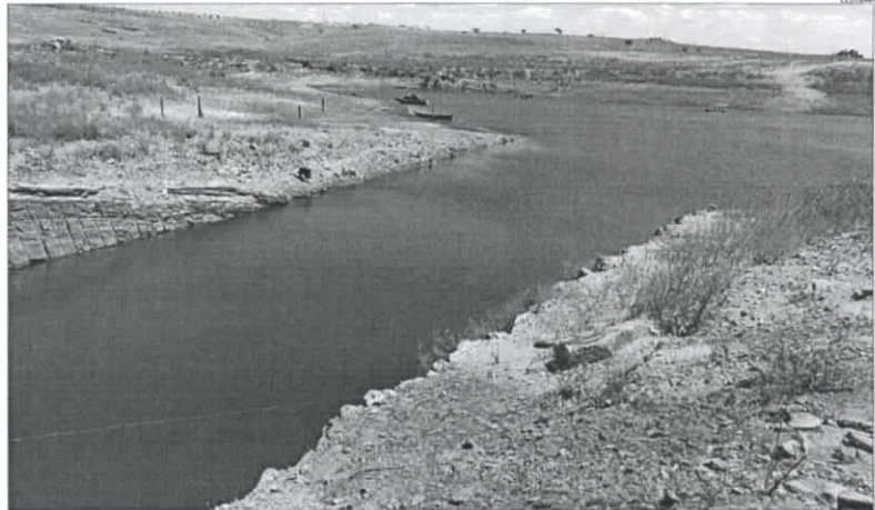
De acordo com o Igar, a barragem Armando Ribeiro Gonçalves opera, atualmente, com apenas 11,74% de sua capacidade
