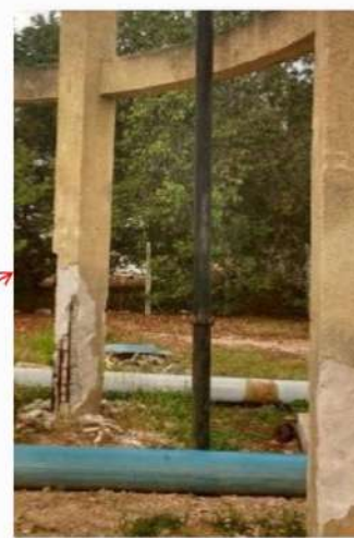
Figura 8 - Reservatório elevado com destacamento da estrutura do concreto e oxidação do aço da estrutura . Fonte: Equipe de elaboração do PMSB., 2017.
