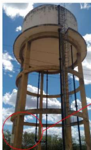
Figura 8 - Reservatório elevado com destacamento da estrutura do concreto e oxidação do aço da estrutura . Fonte: Equipe de elaboração do PMSB., 2017.
