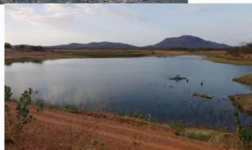
Figura 6 - Sistema de captação de água.
