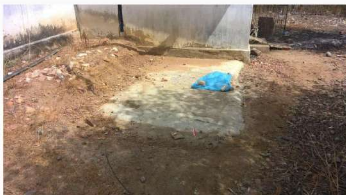
Figura 16 – Fossa rudimentar e esgoto sendo jogado a céu aberto. Fonte: Comitê Executivo do PMSB, 2017.
