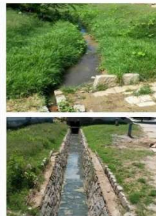
Figura 12: Efluentes lançados a céu aberto e no canal de drenagem.
