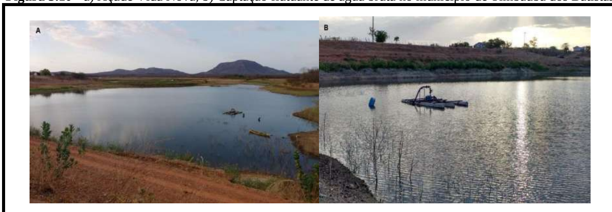
Figura 3.10- a) Açude Vida Nova, b) Captação flutuante de água bruta no município de Timbaúba dos Batistas
