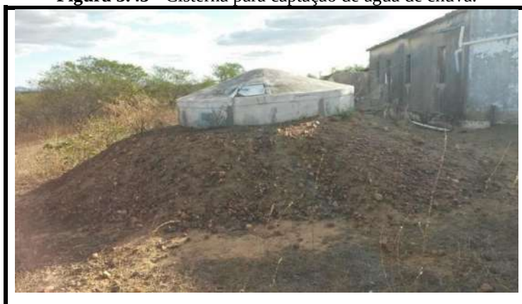
Figura 3.45 - Cisterna para captação de água de chuva.
