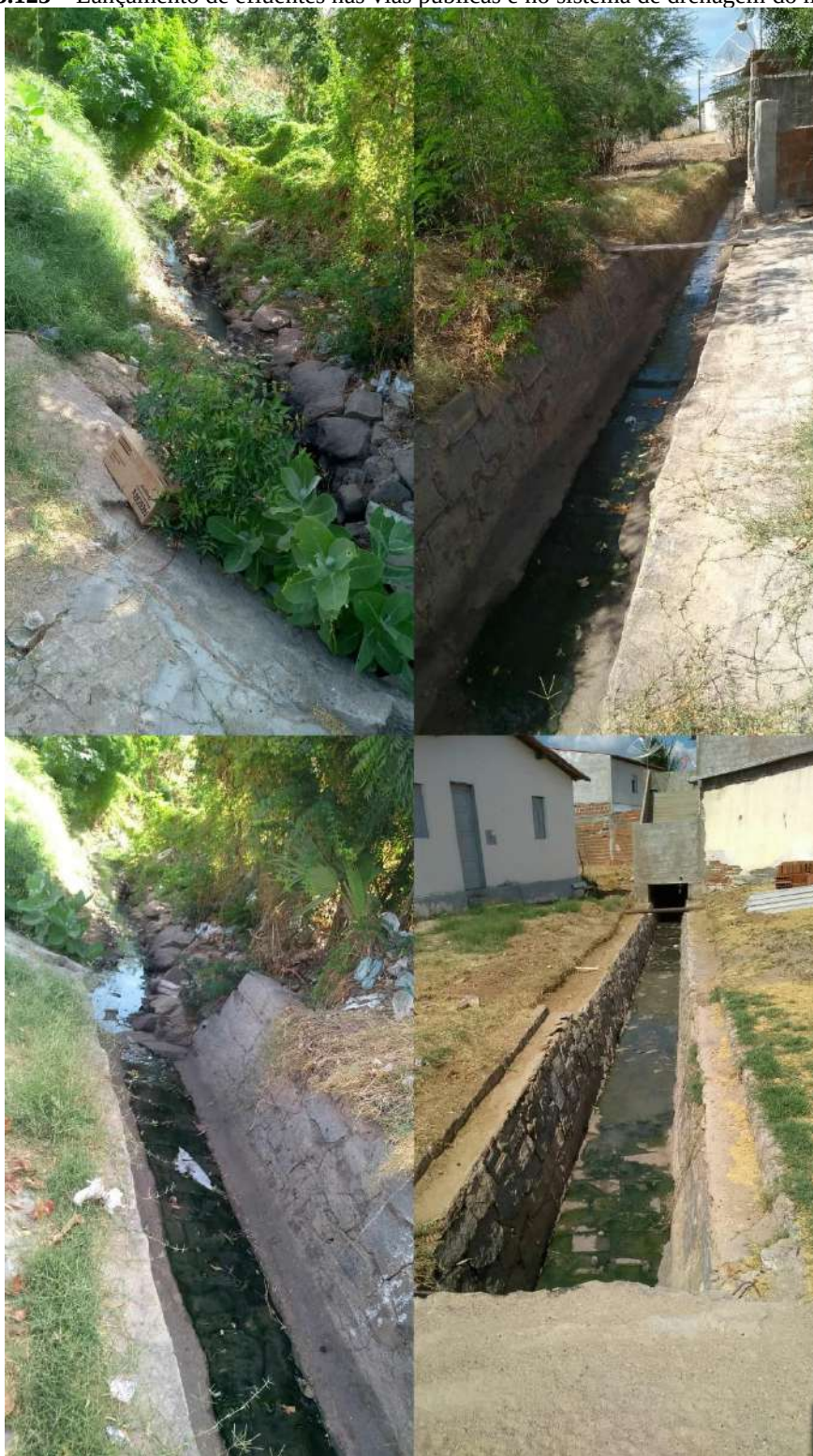
Figura 3.123 – Lançamento de efluentes nas vias públicas e no sistema de drenagem do município.
