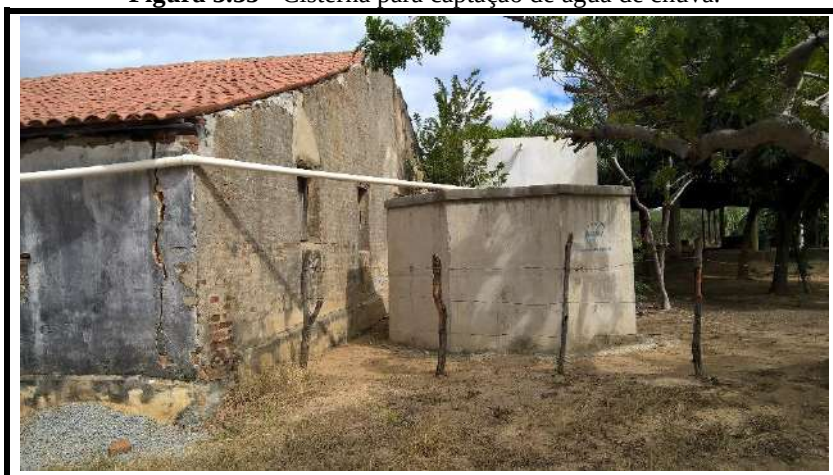
Figura 3.35 - Cisterna para captação de água de chuva.
