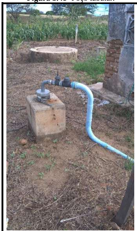
Figura 3.41- Poço tubular.
