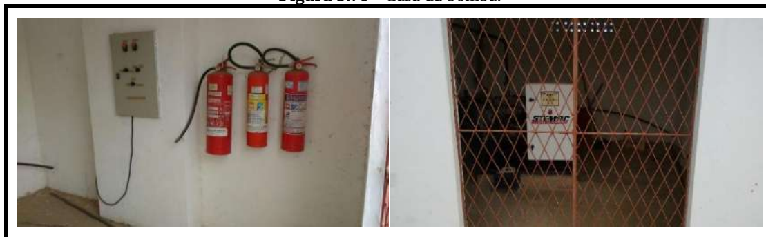
Figura 3.78 - Casa da bomba.
