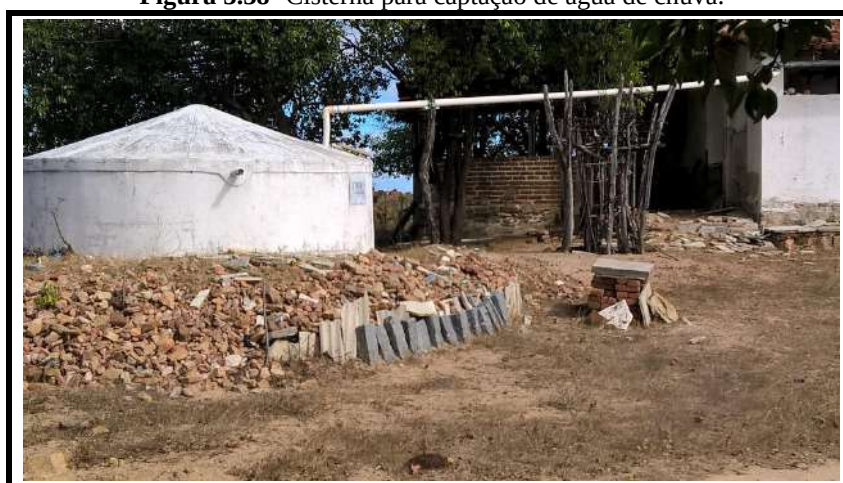
Figura 3.38- Cisterna para captação de água de chuva.
