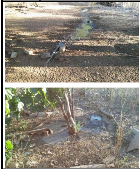
Figura 3.80 – Lançamento de esgoto a céu aberto na zona rural de Timbaúba dos Batistas.
