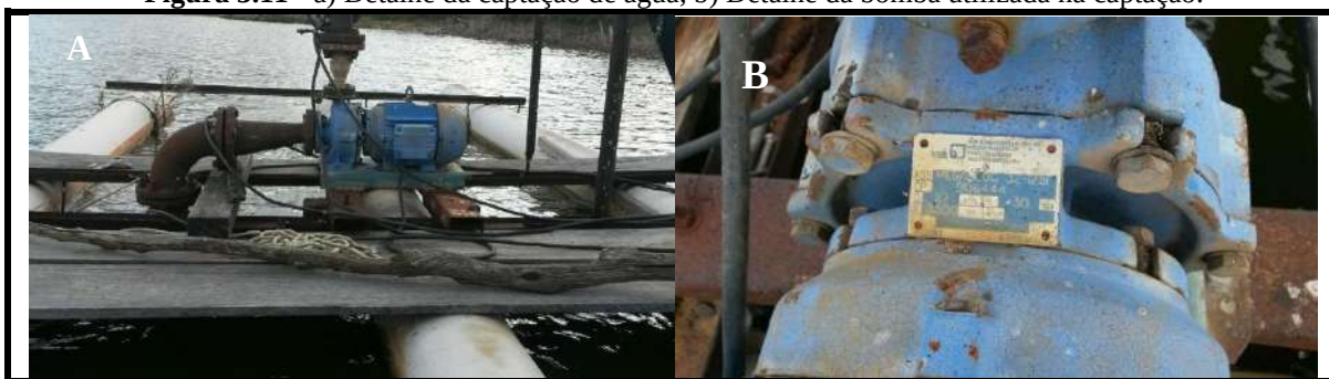
Figura 3.11 - a) Detalhe da captação de água, b) Detalhe da bomba utilizada na captação.
