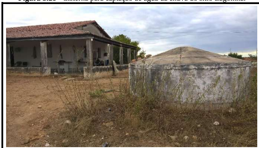
Figura 3.21 - Cisterna para captação de água da chuva do sítio Lagoinha.
