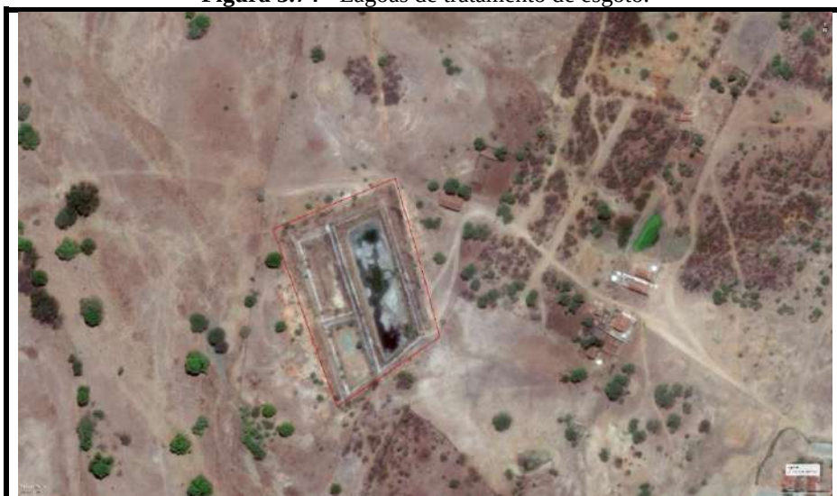
Figura 3.74 - Lagoas de tratamento de esgoto.
