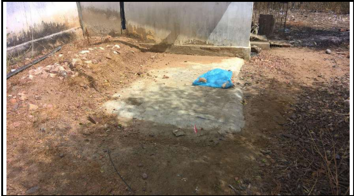
Figura 3.79 - Fossa sumidouro utilizada na zona rural de Timbaúba dos Batistas.
