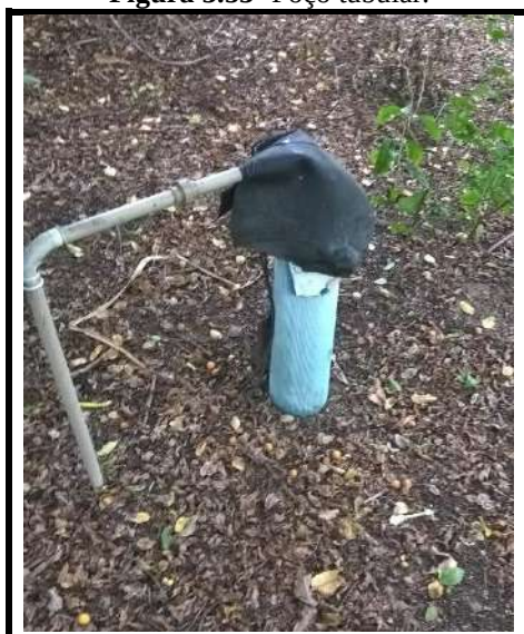
Figura 3.53- Poço tubular.
