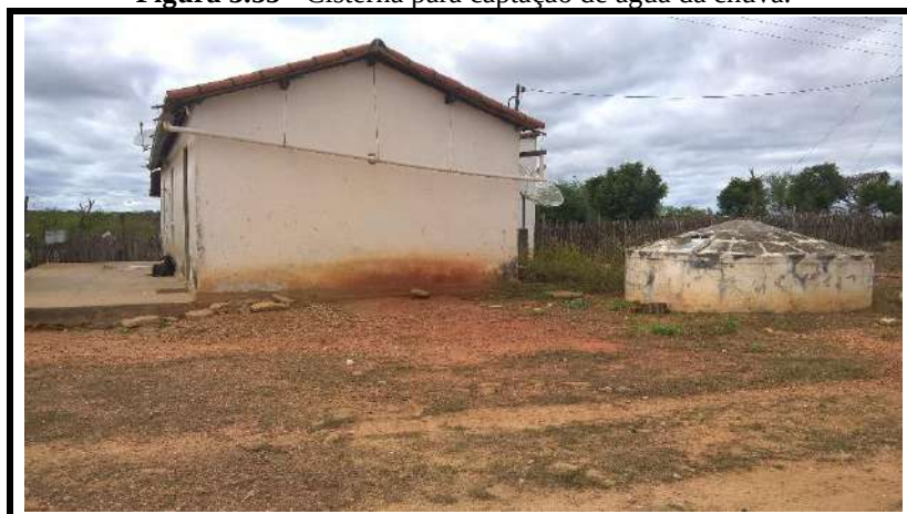
Figura 3.55 - Cisterna para captação de água da chuva.
