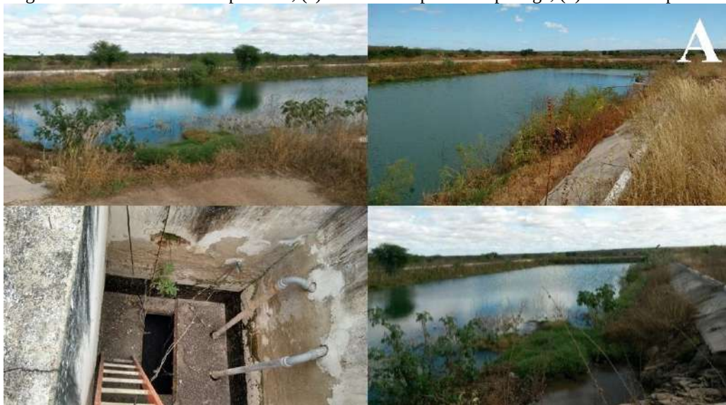
Figura 3.84 – Lagoa de captação com efluentes provenientes do sistema de esgotamento sanitário (a), (b) Esgoto a Céu aberto nas vias públicas, (c) Abatedouro público e pocilga, (d) Cemitério público.
