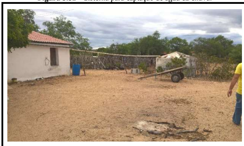
Figura 3.52 - Cisterna para captação de água da chuva.
