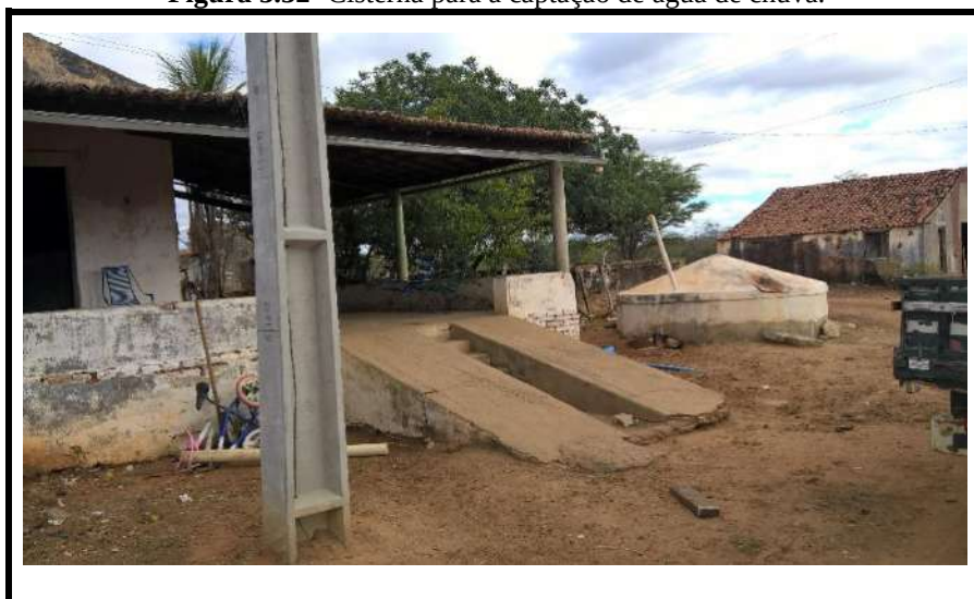
Figura 3.32- Cisterna para a captação de água de chuva.
