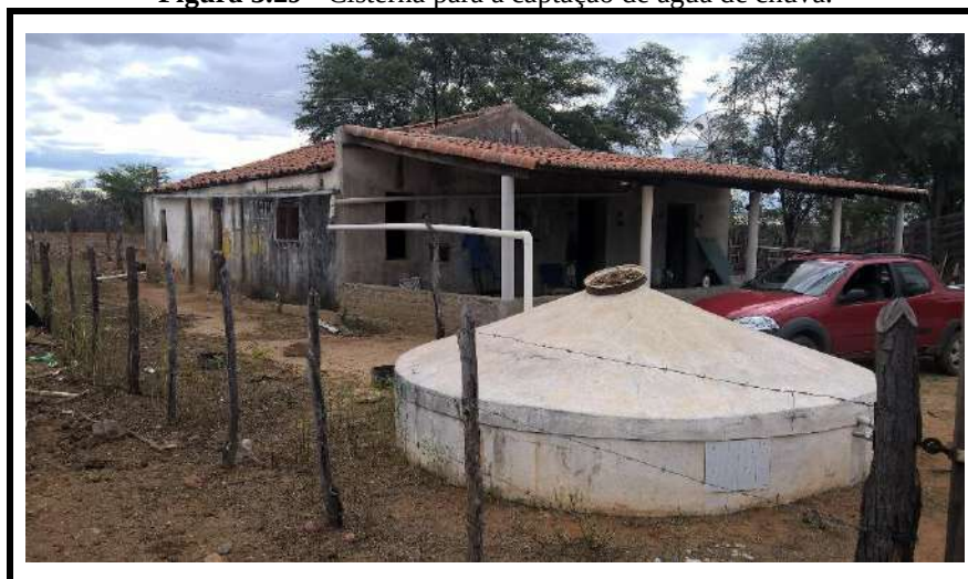
Figura 3.29 - Cisterna para a captação de água de chuva.
