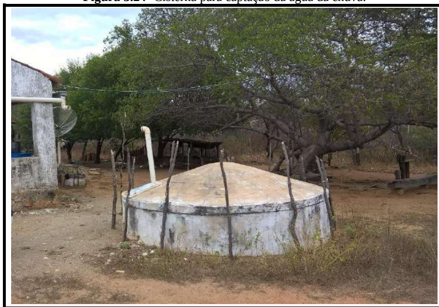
Figura 3.24- Cisterna para captação da água da chuva.
