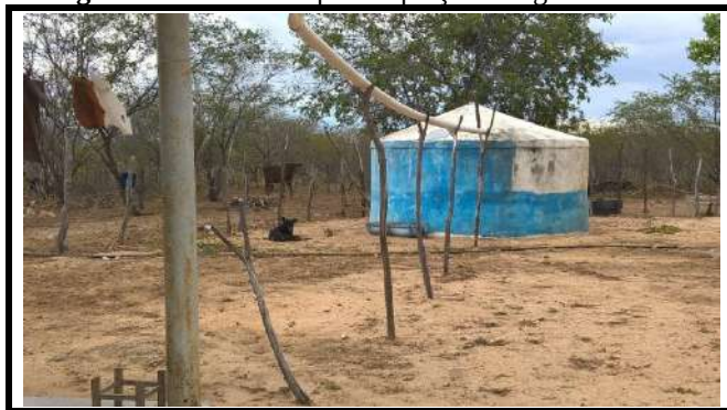
Figura 3.58- Cisterna para captação de água da chuva.
