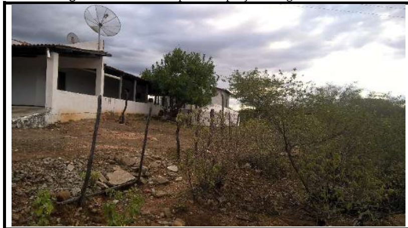
Figura 3.33- Cisterna para a captação de água de chuva.
