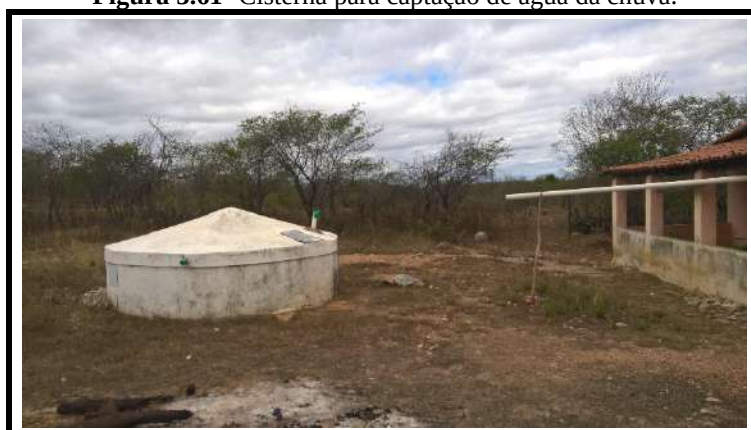
Figura 3.61- Cisterna para captação de água da chuva.
