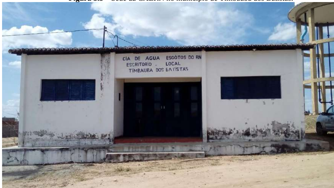
Figura 3.5 – Sede da CAERN no município de Timbaúba dos Batistas.
