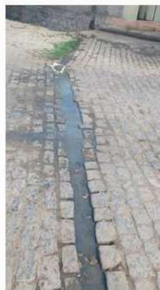
Figura 3: Efluentes lançados a céu aberto e no canal de drenagem.
