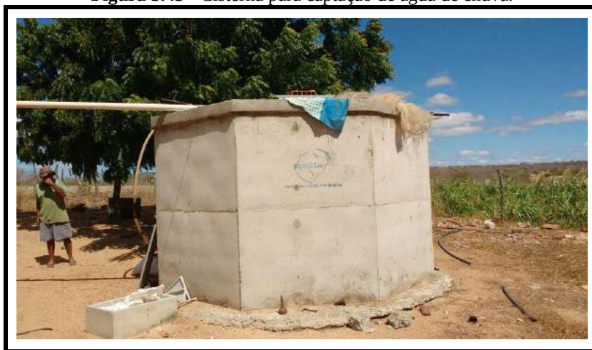
Figura 3.43 - Cisterna para captação de água de chuva.
